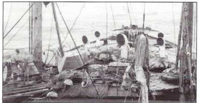
Le "Névé", en pêche, passe devant la "Ville de Fécamp", également en pêche. On voit le chalut de rechange à bord. A gauche, deux matelots font des épissures dans les câbles. - Photo. André Tonnerre
